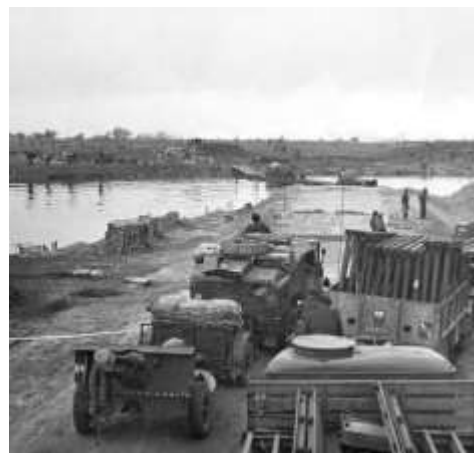
Oversteek over de gelegde pontonbrug
