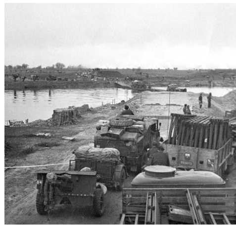
Oversteek over de gelegde pontonbrug
