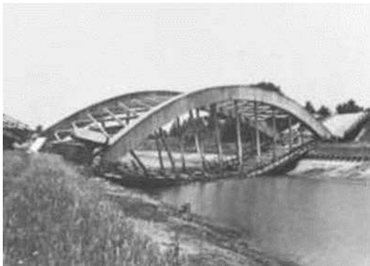
De Brug over het Twentekanaal Lochem opgeblazen. (Foto Beeldbank2wo beeldnummer 73845, collectie NIOD)
